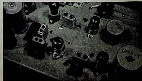
Bild 4. Blick auf den geänderten Chassisteil
